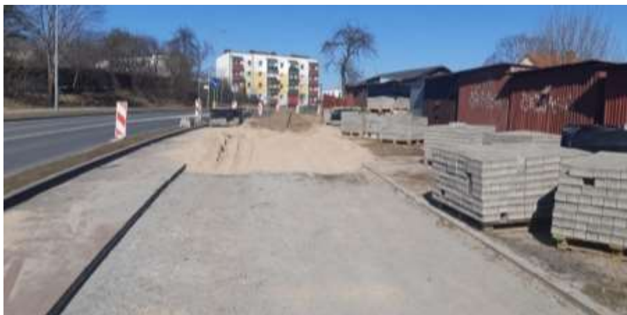
Foto. 5. Budowa kanału deszczowego w ul. Skłodowskiej
