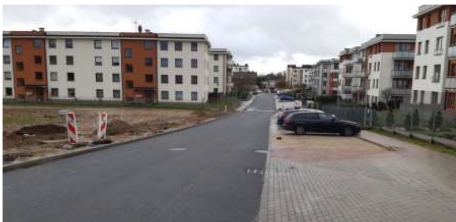
Foto. 9. Ul. Moniuszki – miejsca postojowe i droga
