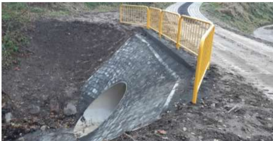
Foto. 6. Przepust pod drogą ul. Markubowo
