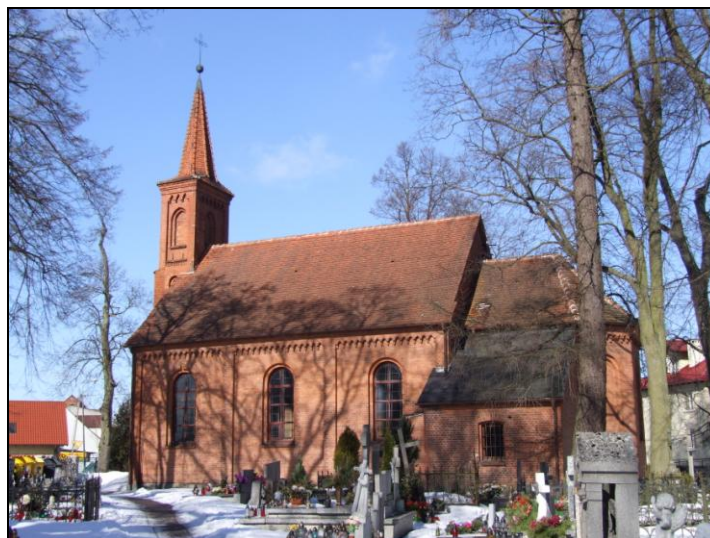
Fot. Widok boczny kościoła cmentarnego pw. Św. Barbary
