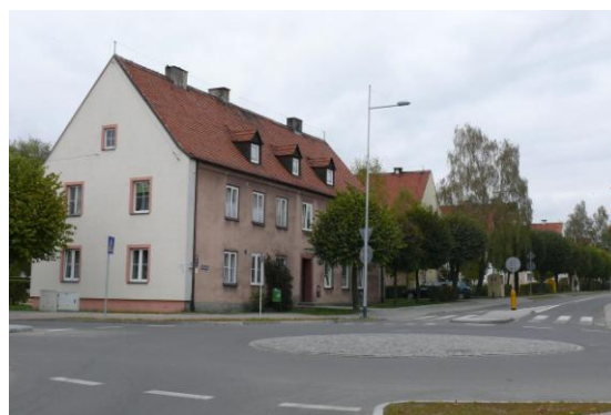
Fot. 6 ul. Sikorskiego (2010r.)
