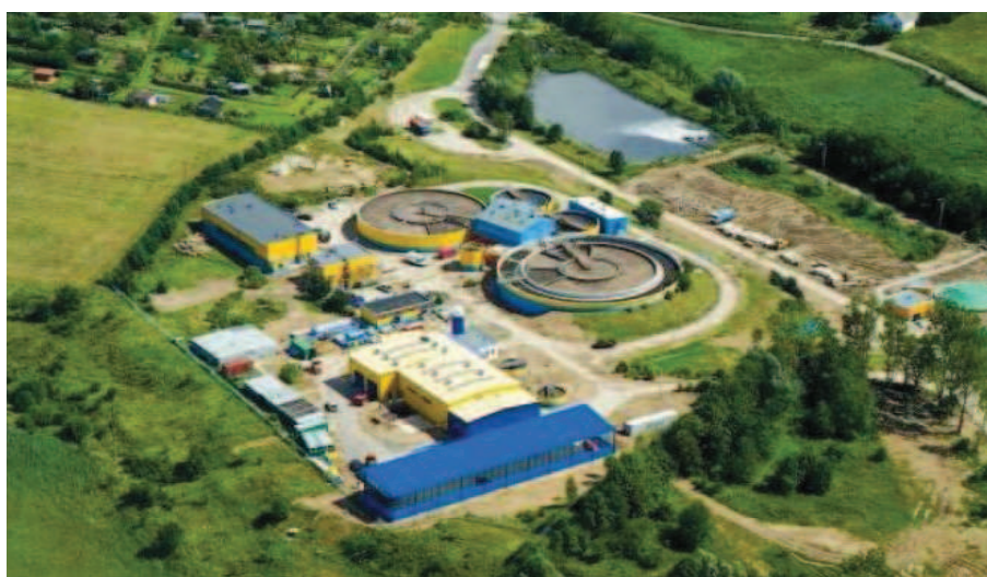
Rys.21. Oczyszczalnia ścieków w Kościerzynie
