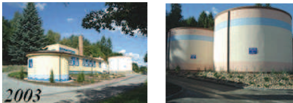
Rys.20. Stacja Wodociągowa w Kościerzynie
