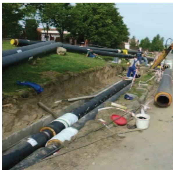
Rysunek 18. Wymiana sieci ciepłowniczej w Kościerzynie (źródło: http://www.monitorurzedowy.pl/ )
