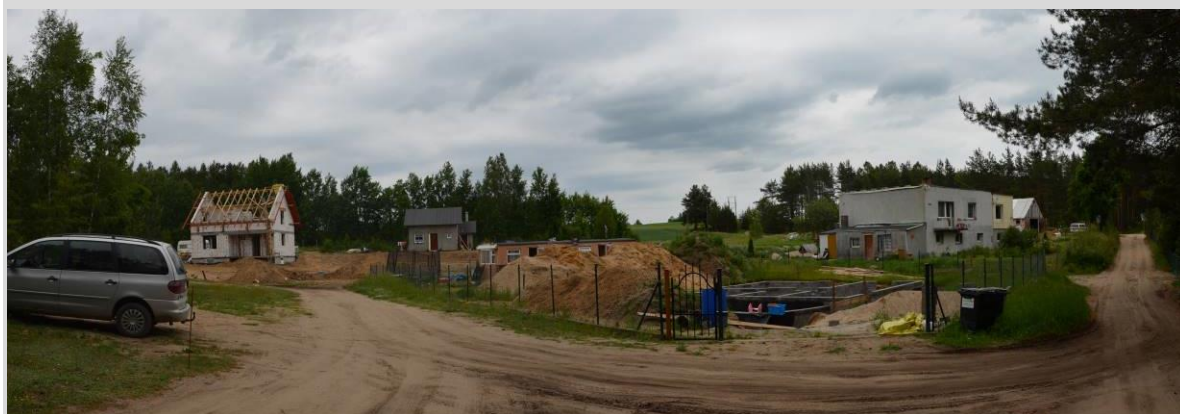
Fot.9 Nowa zabudowa mieszkaniowa jednorodzinna kształtująca się we wschodniej części miasta
