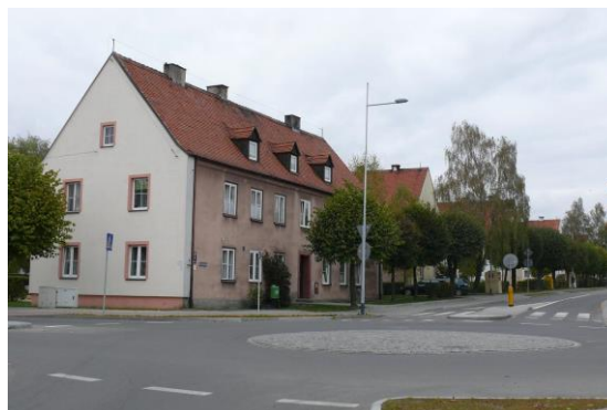
Fot. 6 ul. Sikorskiego (2010r.)
