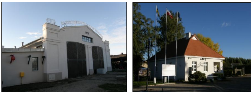
Fot. Zespół parowozowni z halą i budynkiem administracyjnym.
