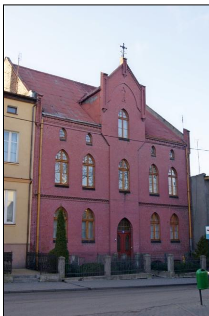
Fot. Fasada klasztoru od str. ul. Kaplicznej.
